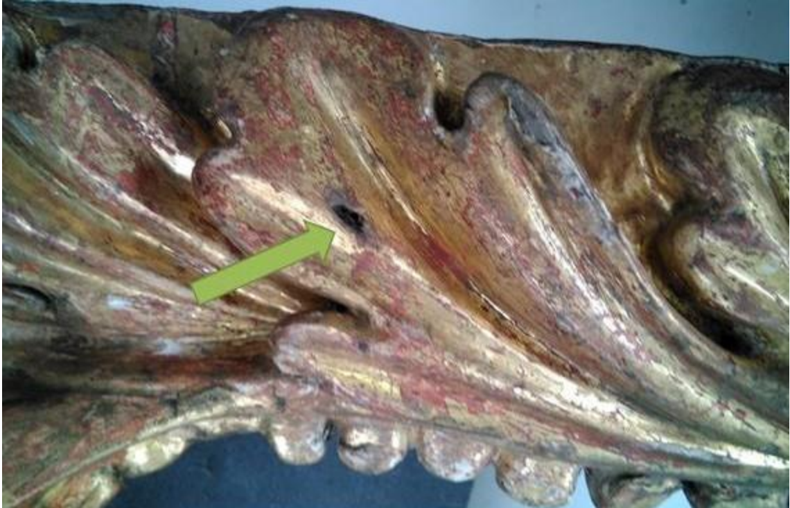
Foto 5. Orificio en la moldura nº 4 con indicios de pudrición.
