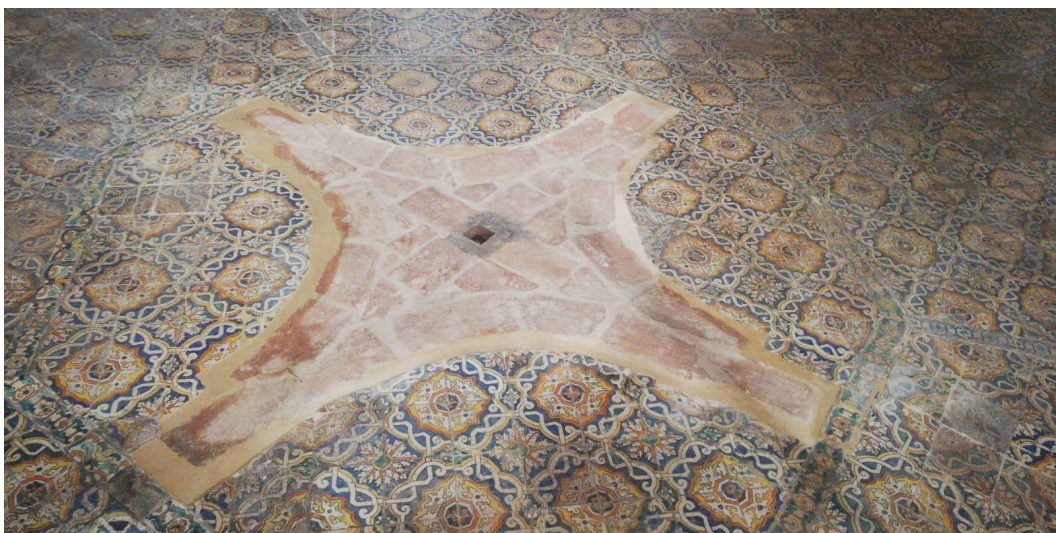
Vista del suelo del camarín una vez fueron reparadas las juntas entre los azulejos.
