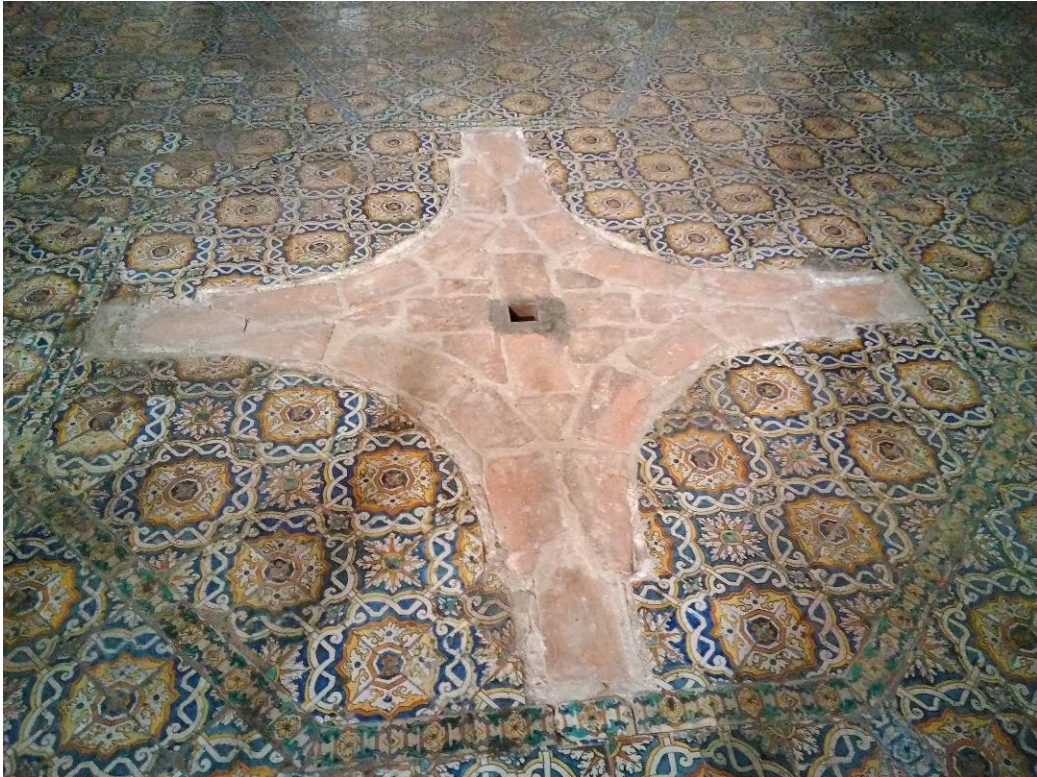
Vista del suelo del camarín una vez desmontado el baldaquino. Se observa en el centro la caja para el alojamiento del extremo del vástago.
